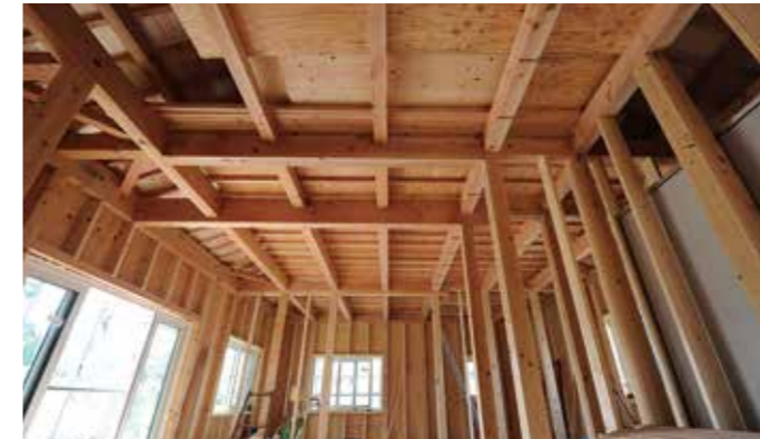
母屋が10年前にソーラーサーキットの家で施工し、同敷地内に新築施工中のお宅もソーラーサーキットの家
