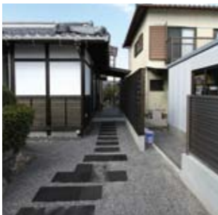
和の外観に合わせた和風の外構は、変型地に合わせて玄関先まで飛び石を施工しました。
