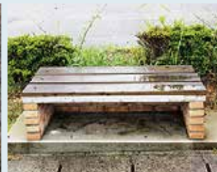
Be-tileのオリジナル製品のひとつ、「防災ベンチ」。平時はベンチとして、災害時には板をはずしてかまどとして使うことができる。(写真は栗東市なごやかセンター内)
