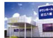
総合葬祭ホール タウンホール近江八幡
