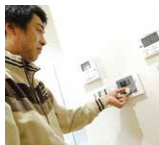
モニターを見ながら季節に合わせて通気口 を開閉。ボタン一つで制御できます。
