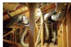
2Fのロフトから上られる屋根裏で、ソーラーサーキット のファンや制御装置もご覧いただくことができます。
