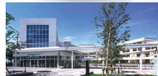
1Fにカフェを併設した地域の交流施設「あまが池プラザ」(写真提供/みらいもりやま21)
